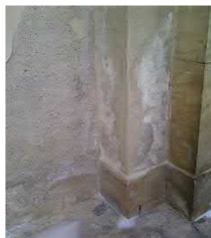
✓ Bestimmung der Feuchte- und Salzbelastung von Mauerwerk
